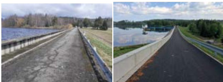
Obrázek 2: SO 01 Rekonstrukce koruny hráze
