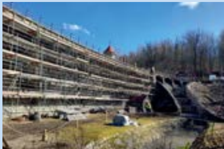
Rozebrání mostovky nad přelivem a práce na vzdušném líci – duben 2023
