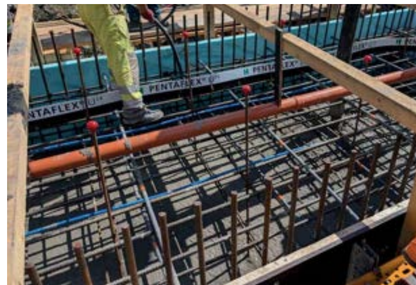
Obrázek 2: Betonáž typické betonové lamely návodní těsnicí stěny. Na fotografii jsou patrné instalované prvky, např.: výztuž, drenážní potrubí (oranžové), polystyren matrice/izolace (tyrkysová), chladicí trubky (modré) a těsnicí plechy.
