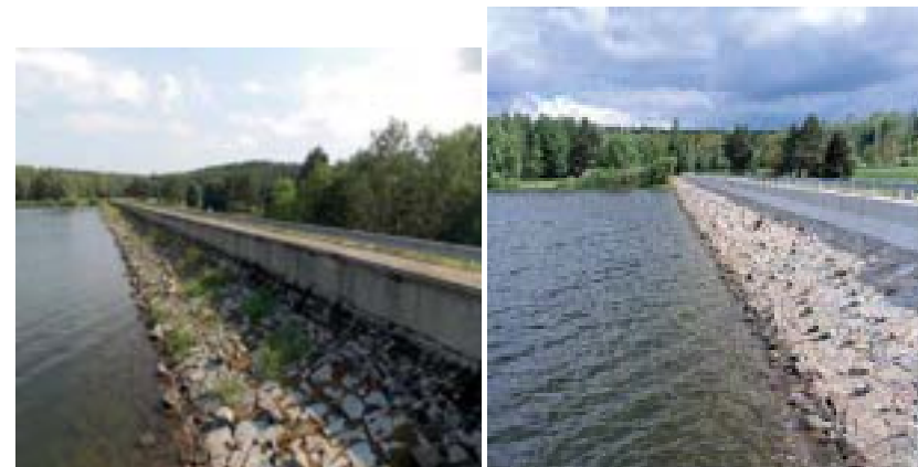
Obrázek 3: SO 02 Sanace návodního opevnění hráze
