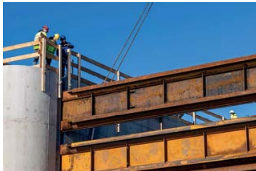
Obrázek 12: Hrazení probíhalo zároveň jako součást suchých zkoušek technologie za dohledu zástupců všech účastníků stavby.
