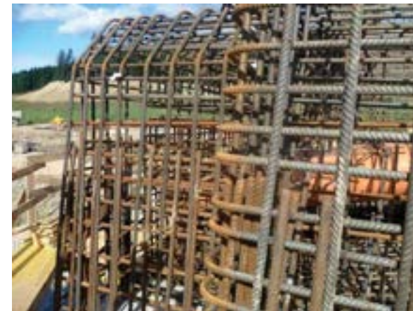
Obrázek 2: Křížení výztuže ŽB konstrukce sdruženého objektu SN Jelení
