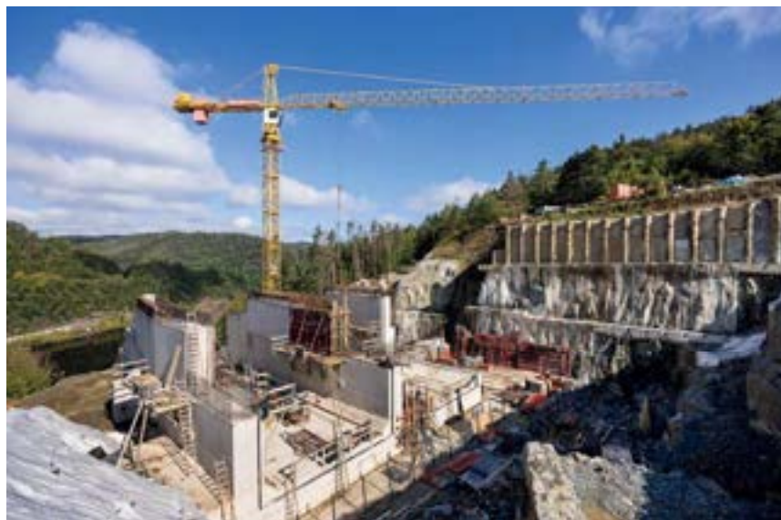
Obrázek 2: ... a zatím co se na návodní straně uklízelo, za hrází pokračovaly betonáže stěn posledních bloků stavebního objektu SO 02 – krytá část skluzu.
