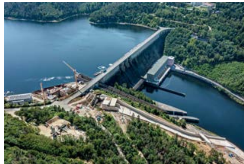
Obrázek 9: Celkový pohled na VD s demontovaným jeřábem na SO 03 – otevřená část skluzu. Železobetonové konstrukce na SO 03 jsou kompletně dokončeny, probíhá dokončování přemostění skluzu a realizace schodišť a dalších dokončovacích prací.
