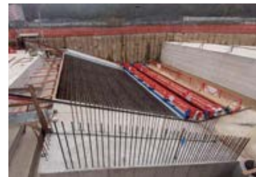
Obrázek 3: Zkušební blok před betonáží poslední části s připraveným finišerem.
