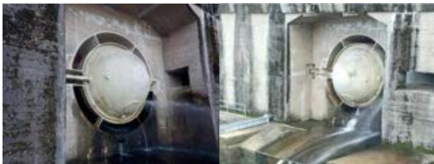
Obrázek 6: Vývoj průsaků skrze uzávěr v průběhu přípravy oprav
