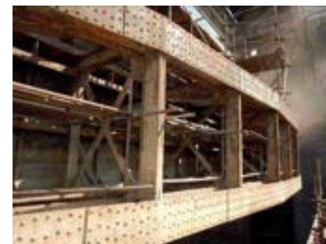
Obrázek 4: Pohled na konstrukci dolní tabule při opravě v roce 2023
