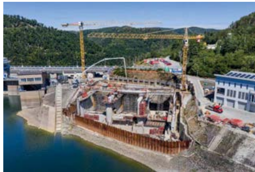
Obrázek 9: Výstavba vtokového objektu – srpen 2025
