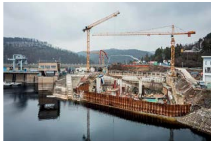
Obrázek 5: SO 01–v únoru 2025 jsou již patrné kontury jednotlivých tubusů.
