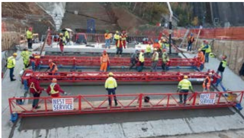
Obrázek 4: Betonáž poslední části zkušební bloku
