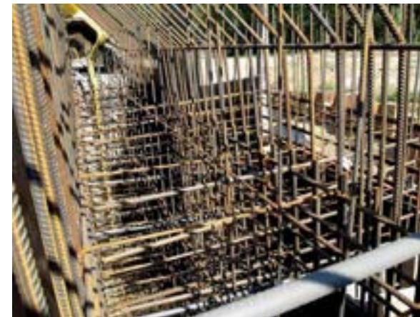
Obrázek 5: Výztuž sruženého objektu VD Baška
