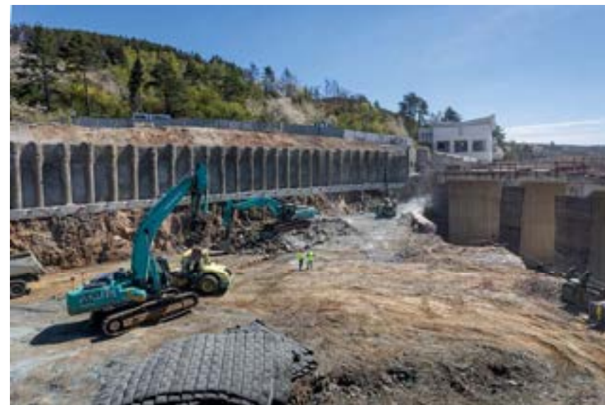
Obrázek 20: Probíhající těžba na druhou kotevní úroveň – duben 2026.
