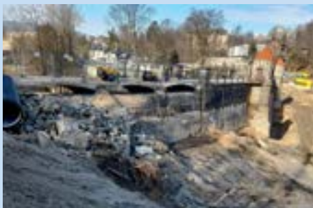
Rozebrání mostovky nad přelivem a práce na vzdušném líci – duben 2023
