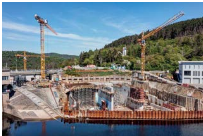
Obrázek 7: Armování prvního stropu na vtoku – tubus č. 1, květen 2025.
