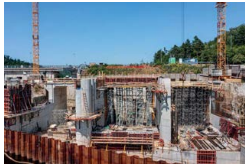
Obrázek 8: Letní období rozhodně neznamenalo prázdniny pro stavbu. Červenec 2025 a zřetelný postup prací na SO 01.
