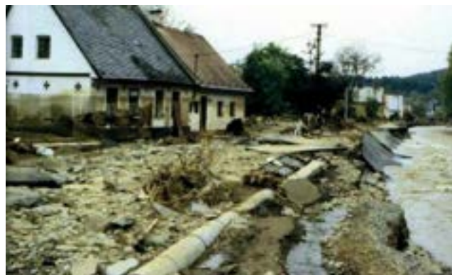
Obrázek 1: Následky povodně v roce 1996 v obci Lichnov
