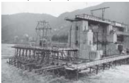
Obrázek 1: Stavba pilířů a montáž ocelových konstrukcí
