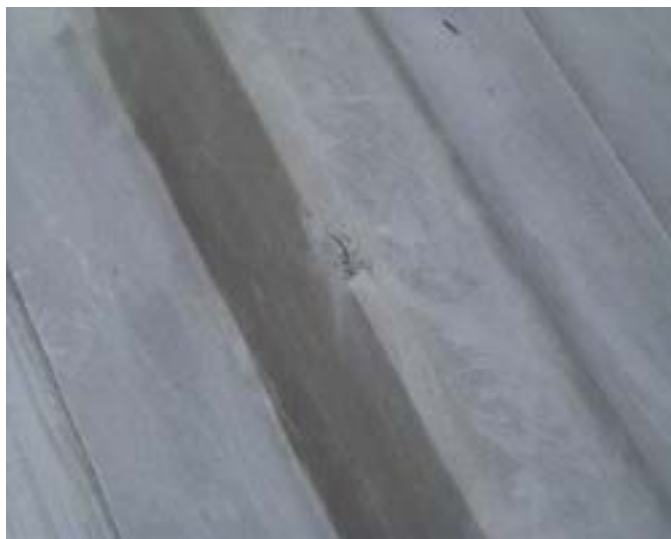
Obrázek 5: Geomembrána poražená hrotem běžecské hole (VD Morávka)
