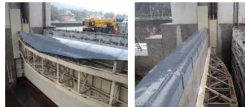
Obrázek 3: III. Jezové pole, opravená hradicí konstrukce v roce 2015
