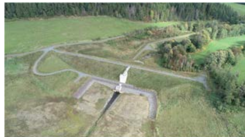
Obrázek 3: Uspořádání ORN Lichnov II (AQUATIS 3.10.2019) Nádrž je vypuštěná, opevnění odpovídá prostoru stálého nadržení.
