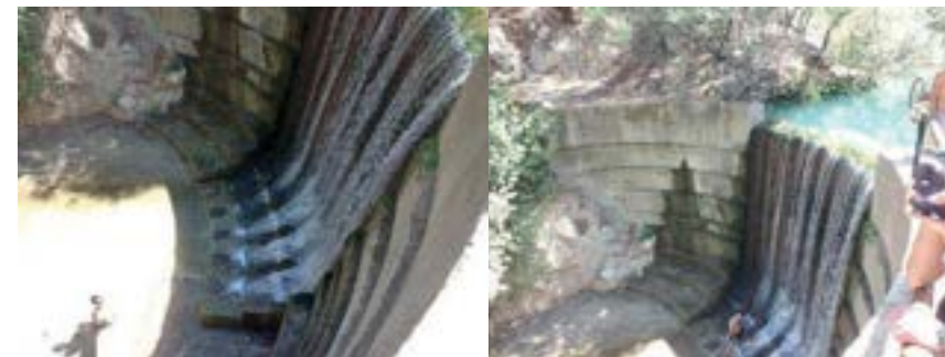
Obrázek 1: Malá klenbová přehrada na bezejmenném vodním toku v oblasti sedmi pramenů na řeckém ostrově Rhodos.
