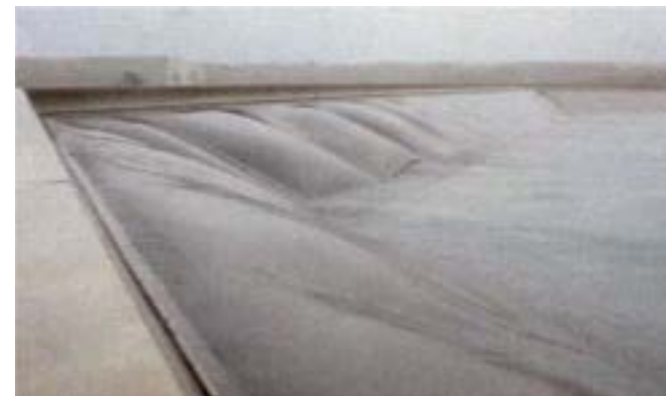
Obrázek 4: Horní nádrž PVE Okinawa s těsněním geomembránou zatíženou větrem
