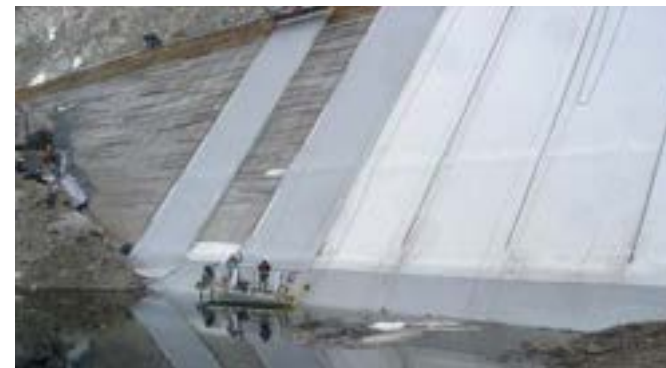
Obrázek 3: Oprava dřevěného pláště přehrady Sabrina dam s využitím geomembrány
