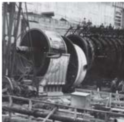
Obrázek 2: Montáž vstupního kusu, jehly a spodku střední části jehlového uzávěru s dutým výtokovým paprskem na spodní výpust VD Orlik v roce 1959 (pohled částečně proti vodě)
