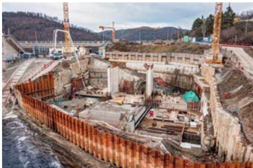
Obrázek 3: Po říjnovém úklidu pracoviště byly v listopadu obnoveny práce na železobetonových konstrukcích SO 01, stav k 12/2024.
