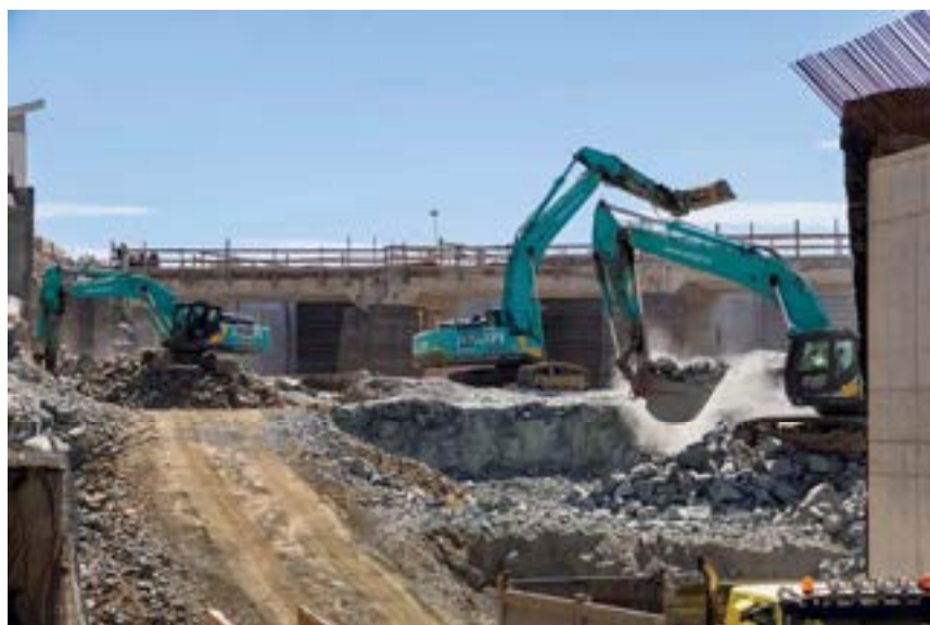
Obrázek 19: Souhra stavebních strojů v jámě SO 02.
