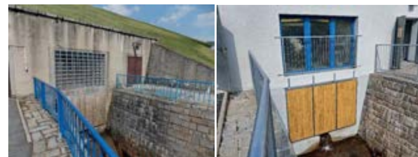
Obrázek 5: Portál komunikační a odtokové chodby
