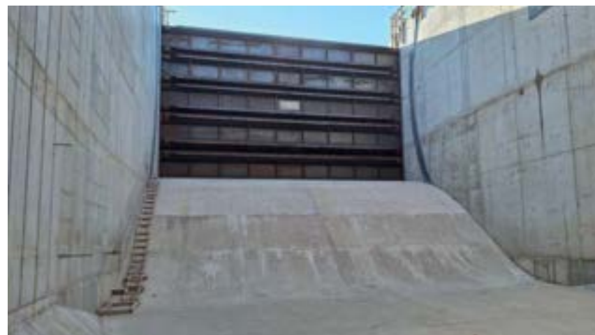
Obrázek 10: Pohled do jednoho ze tří tubusů bezpečnostního přelivu na přelivnou hranu a provizorní hrzení
