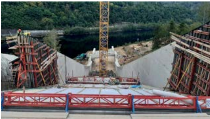
Obrázek 7: Výstavba horní části skluzu
