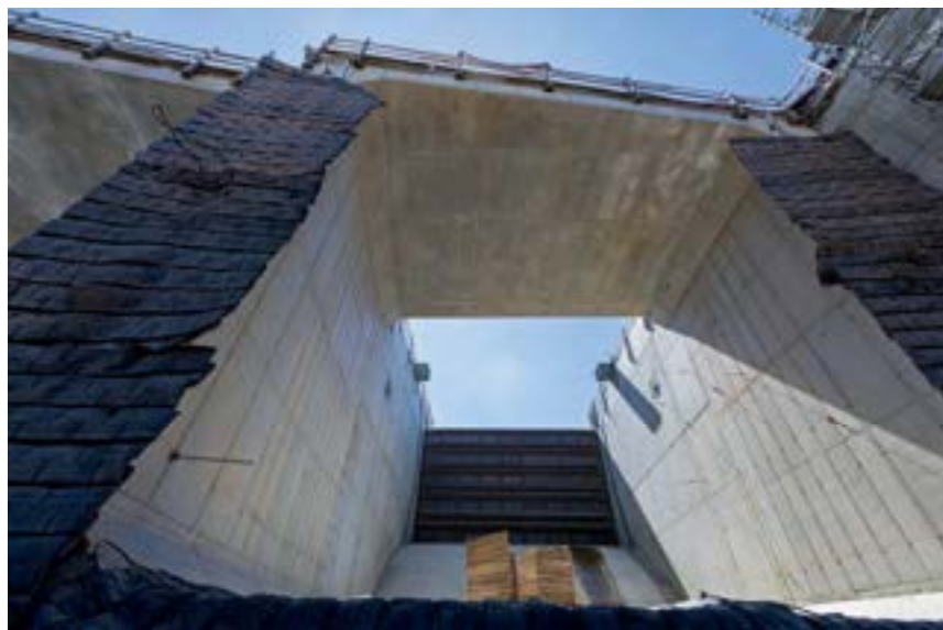
Obrázek 18: Dokončené konstrukce stavby stejně jako okolí SO 02 je potřeba chránit před rozletem úlomků při provádění trhacích prací.
