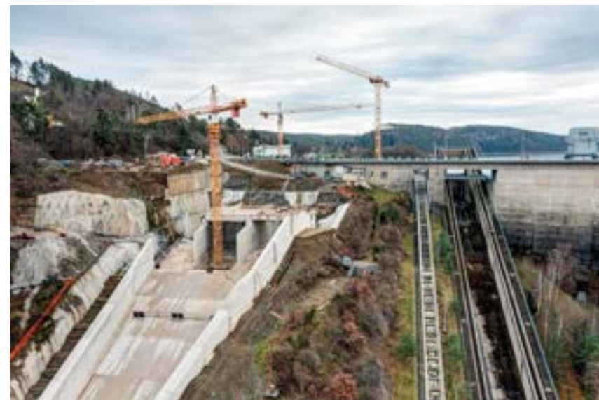
Obrázek 4: Dokončené stropy na hranici dvou největších objektů SO 02 a 03, stav k 12/2024
