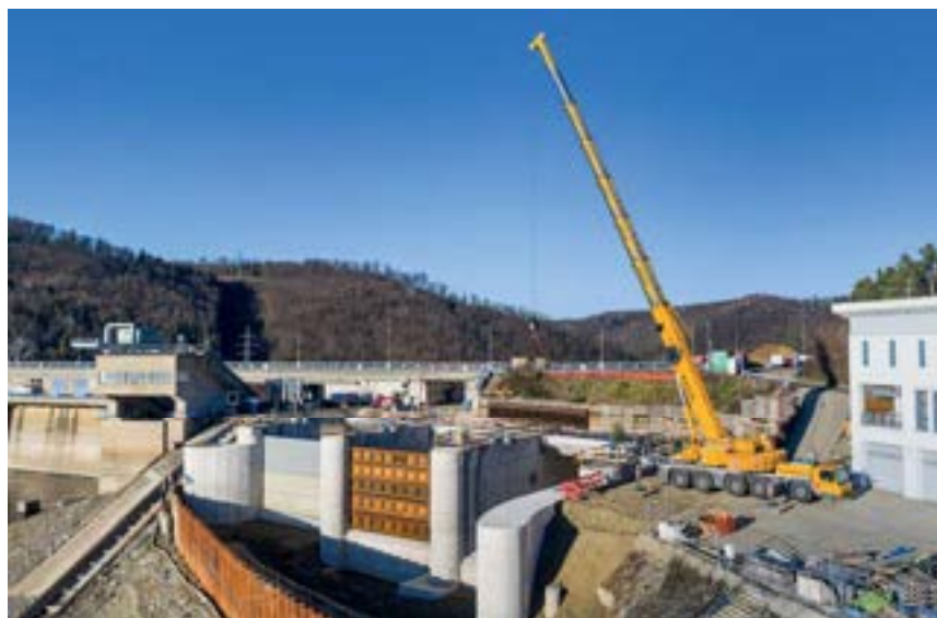
Obrázek 11: v prosinci 2025 jsou dokončovány práce na SO 01 na hydrostatické části objektu. Ten převezme brzy ochrannou funkci celé stavby. Na fotce provádění hrazení tubusu č. 3.
