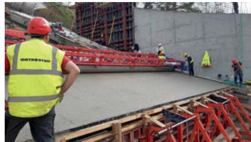
Obrázek 5: Betonáž vlastní konstrukce skluzu – úprava povrchu betonu válcovým rotačním finišerem
