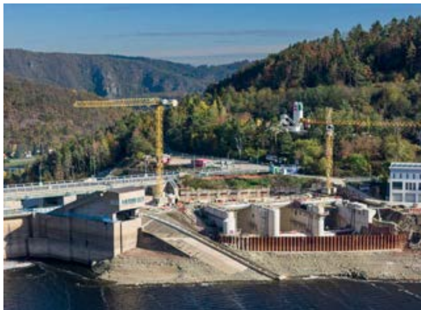
Obrázek 10: Po dalších 3 měsících již dokončeny betonáže vtoku SO 01–říjen/2025.
