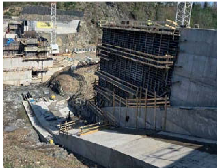
Obrázek 3: Pohled na budoucí vzdušní líc hráze. v popředí levobřežní těsnicí část (dilatační bloky 3 a 2). v pozadí funkční objekt (dilatační blok 7).
