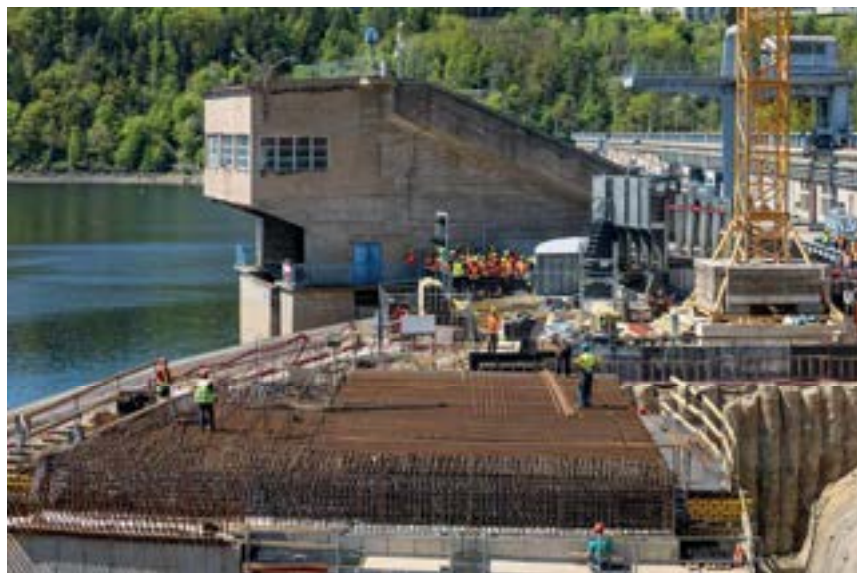
Obrázek 6: Květen 2025 – jaro a léto je na stavbě vždy ve znamení exkurzí. V popředí patrná montáž armatury stropu levého tubusu (tubus č. 1) na SO 01.
