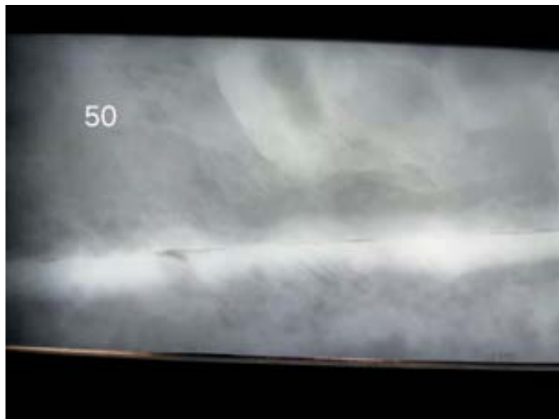
Obrázek 6: RTG snímek - další příklad vady svarového spoje na potrubí DN600
