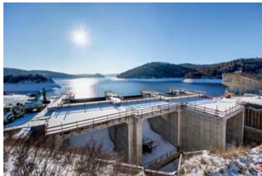
Obrázek 13: v lednu 2026 přebírá vtokový objekt SO 01 od dočasné návodní jímky ochrannou funkci. Nyní je možné zahájit demolicí části tělesa hráze a začít tak s vlastní stavbou SO 02 – krytá část skluzu.
