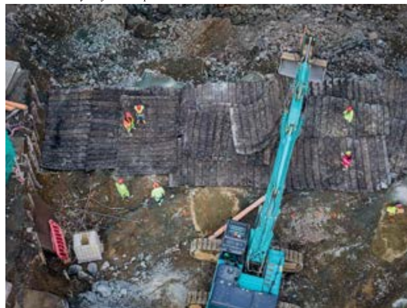
Obrázek 17: v únoru 2026 bylo zahájeno rozpojování horniny. Čeká nás odstranit přes 40 000 m 3 amfibolitu.
