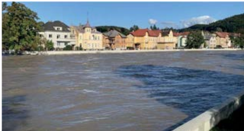
Obrázek 5: Hranice, 15. 9. 2024. Průtok dosáhl 700 \text{ m}^3/\text{s} . Díky již vybudovaným lokálním PPO (s využitím bezpečnostního převýšení nad návrhovou hladinou) nedošlo za povodně 2024 k přelítí. Další zvýšení úrovně ochrany je možné jen s využitím transformace nádrží VD Skalička.
