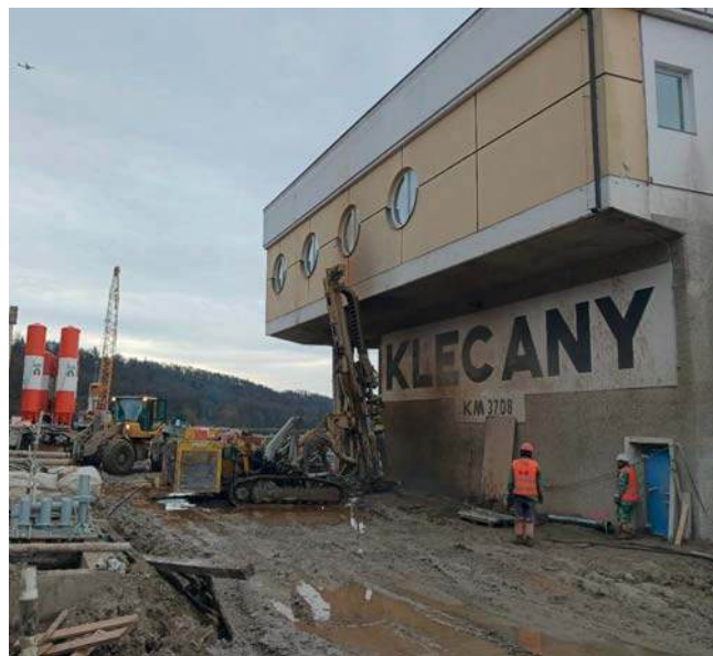
Obrázek 2: Provádění tryskové injektáže u velínu jezu
