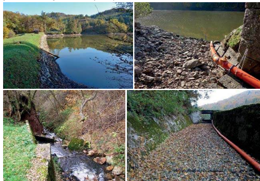
Obrázok 15: Vodná stavba Halčiansky tajch - súčasný stav vodnej stavby
