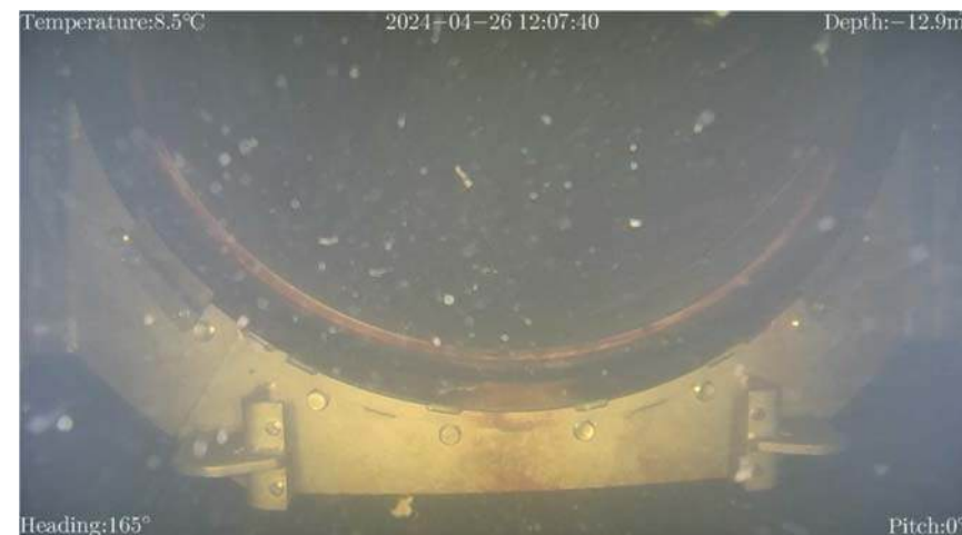
Obrázek 8: Spodní výpust, dolní část
