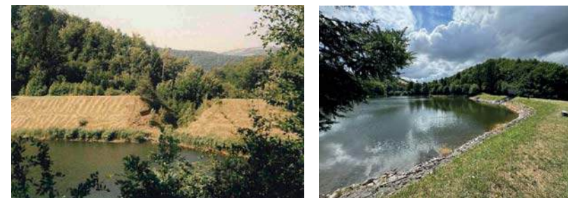
Obrázok 14: Vodná stavba Moderštolňa – porovnanie nefunkčnej vodnej stavby s prekopanou hrádzou a stavu po rekonštrukcii (Zdroj: archív SVP, š.p.)
