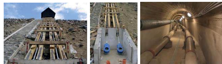
Obrázok 3: Vodná stavba Rozgrund - rekonštrukcia v roku 2004 (Zdroj: archív SVP, š.p.)
