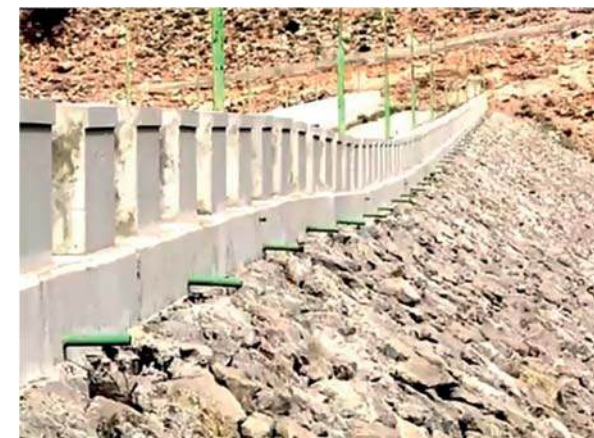
Obrázek 3: Viditelné svislé deformace koruny hráze přehrady Monsour [1]
