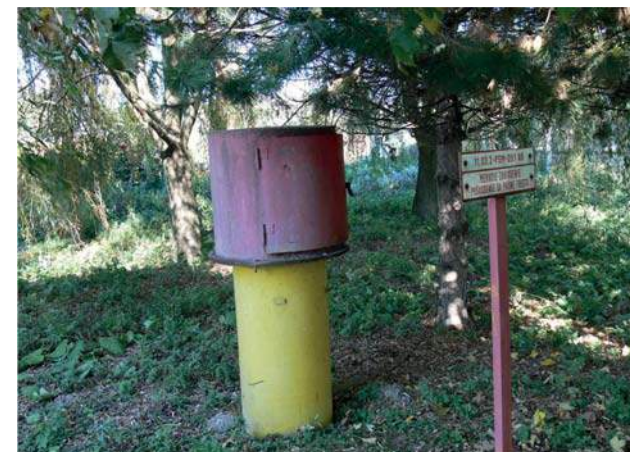
Obrázok 1: Pohľad na sondu PSM-081 v Bodíkoch (Prívodný kanál – pravé zázemie v km 9,500 rade B)
