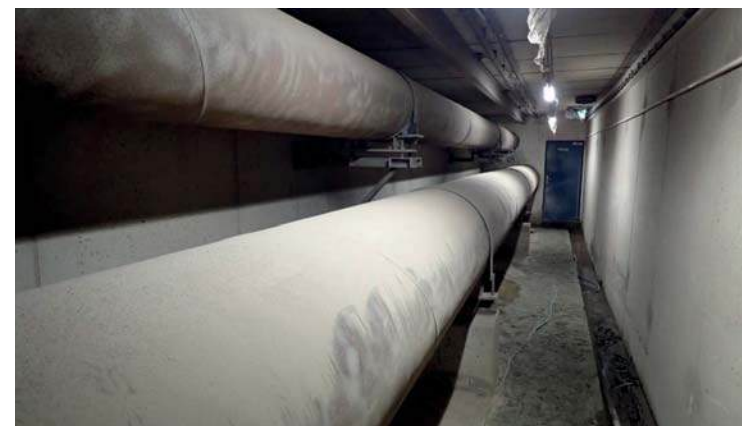
Obrázok 4: Prívodné potrubia DN 500 a DN 800 na MVE
