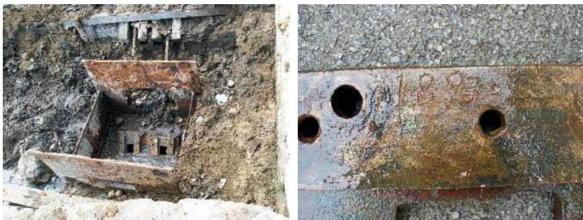
Obrázok 8: Vodná stavba Veľká Kolpašská - pôvodné dnové výpusty vodnej stavby (Zdroj: archív SVP, š.p.)
