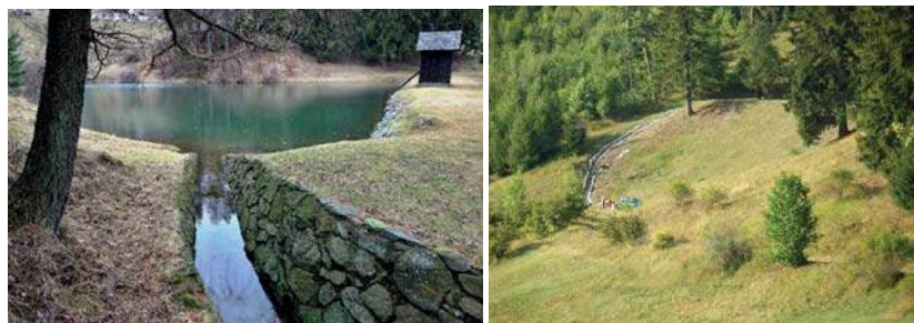
Obrázok 13: Vodná stavba Ottergrund - budovanie bezpečnostného priepadu, 2009 (Zdroj: archív SVP, š.p.)
