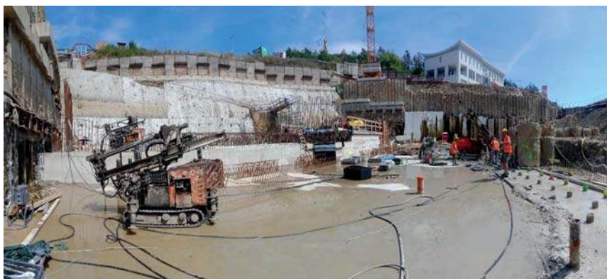
Obrázek 5: Realizace injekční clony na SO 01
