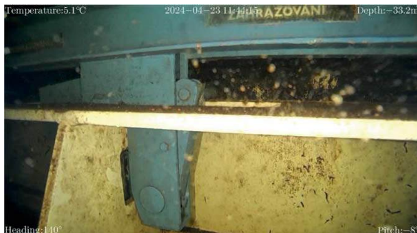
Obrázek 3: Zdvízná traverza a tabule provizorního hrazení na VD Josefův Důl
