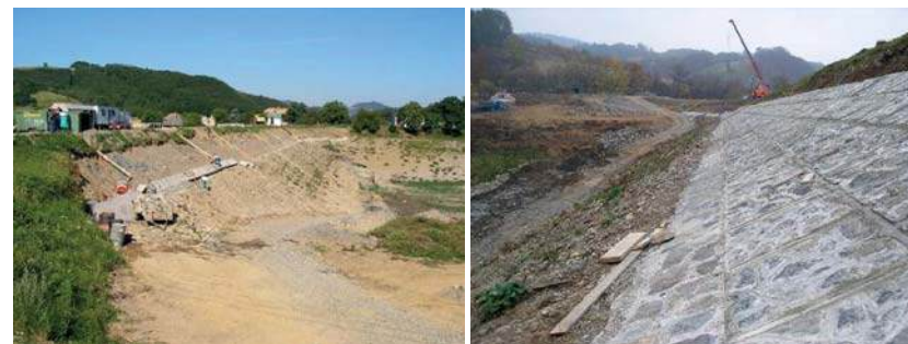
Obrázok 10: Vodná stavba Veľká Kolpašská - rekonštrukčné práce 2007–2008 - úprava a opevňovanie návodného svahu hrádze vrátane obnovy stabilizačných a ochranných prvkov (Zdroj: archív SVP, š.p.)
