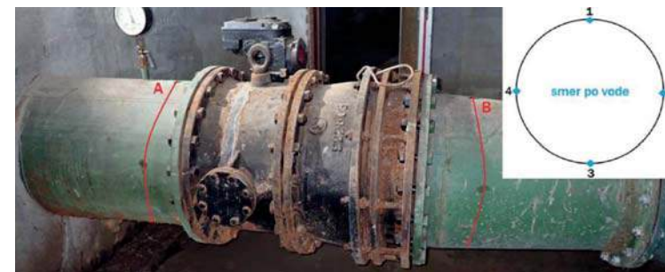
Obrázok 2: Umiestnenie meracích profilov a bodov na výtlačnom potrubí DN 600/DN 800
