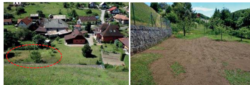
Obrázok 11: Vodná stavba Veľká Kolpašská - podhrádzový priestor s prejavmi podmáčania územia a následne upravenou plochou po realizácii doplnkových drenážnych opatrení, 2021 (Zdroj: archív SVP, š.p.)
