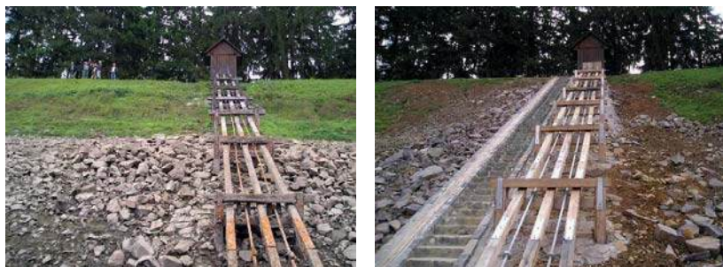
Obrázok 5: Vodná stavba Bakomi - výmena pôvodného systému na manipuláciu s dnovými výpustmi, 2006 (Zdroj: archív SVP, š.p.)
