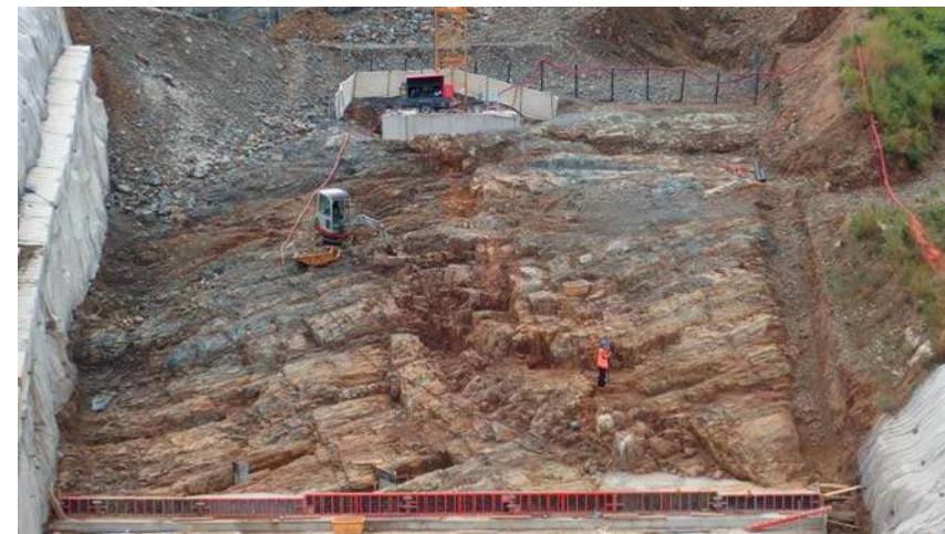
Obrázek 3: Úprava povrchu základové spáry SO 03 blok 37-39
