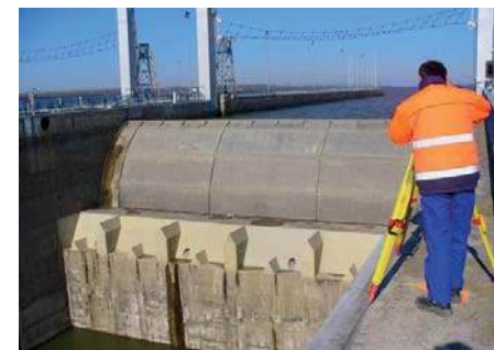
Obrázok 4: Náročné klimatické podmienky pri meraniach konštrukcií Plavebných komôr na stupni Gabčíkovo
