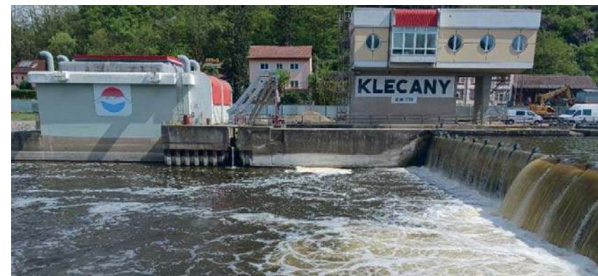
Obrázek 1: VD Klecany – Roztoky, velín a stávající MVE před zahájením stavby
