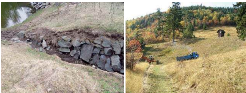
Obrázok 12: Vodná stavba Ottergrund - stav pred vybudovaním bezpečnostného priepadu (Zdroj: archív SVP, š.p.)
