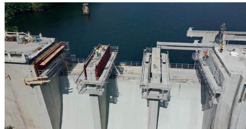
Obrázek 4: Příprava úložných prahů před osazením nových nosníků
