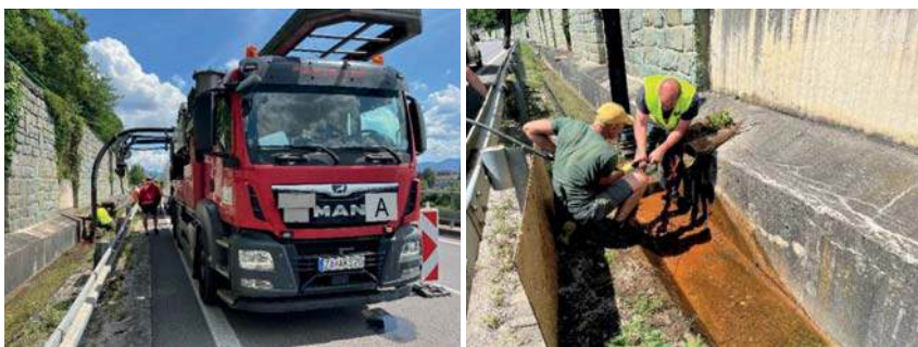
Obrázok 2: Čistenie odvodňovacích vrtov v lokalite Dubeň I. v roku 2024
