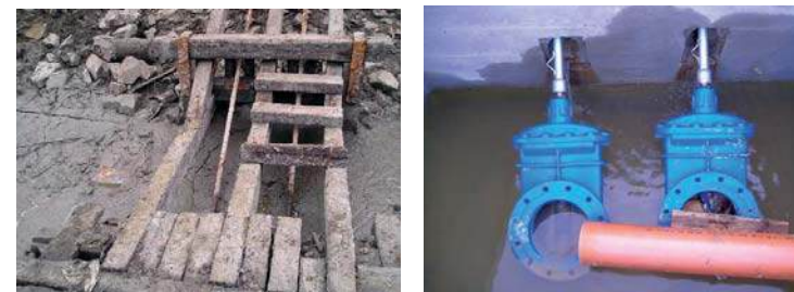
Obrázok 6: Vodná stavba Bakomi - pôvodné a nové dnové uzávery vodnej stavby po rekonštrukcii v roku 2006 (Zdroj: archív SVP, š.p.)
