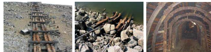
Obrázok 2: Vodná stavba Rozgrund - pôvodný stav (Zdroj: archív SVP, š.p.)
