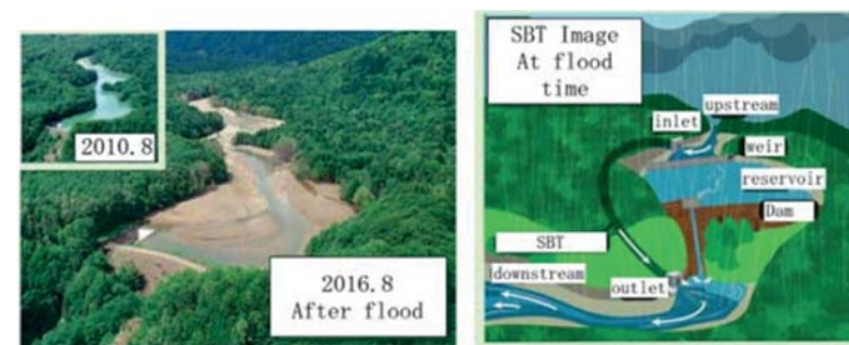
Fotografie nádrže Horoka před a po povodni a schéma sedimentačního obtokového tunelu (SBT)
