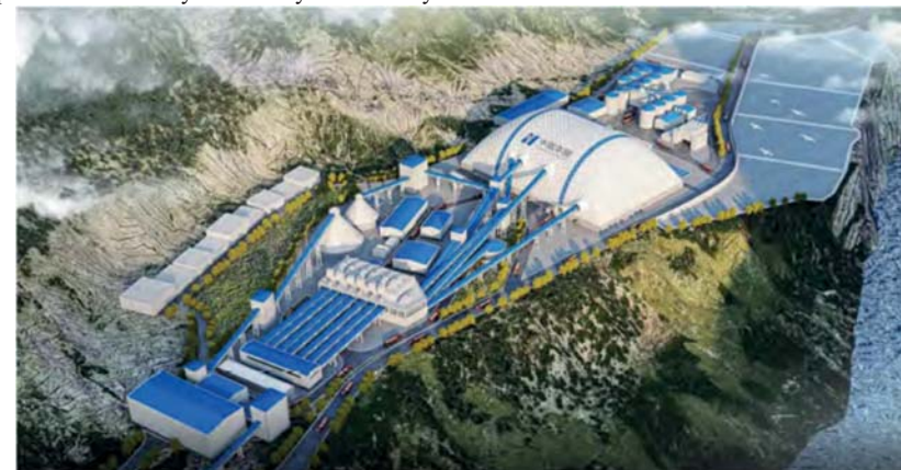
3D návrh 51 000m 2 skladu písku a štěrku pro výrobu betonu. Požadovaná kapacita výroby betonu - 130,000 m 3 /měsíc
