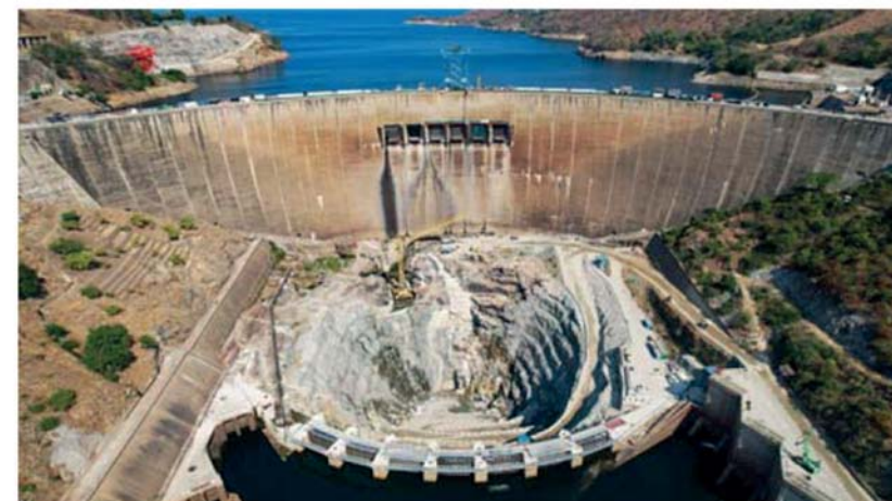
Celkový pohled na dokončovací práce na úpravě vývaru pod klenbovou hrází (červenec 2024)
