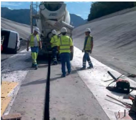
Rýha v ose kanálu pro umístění optického měřicího kabelu
