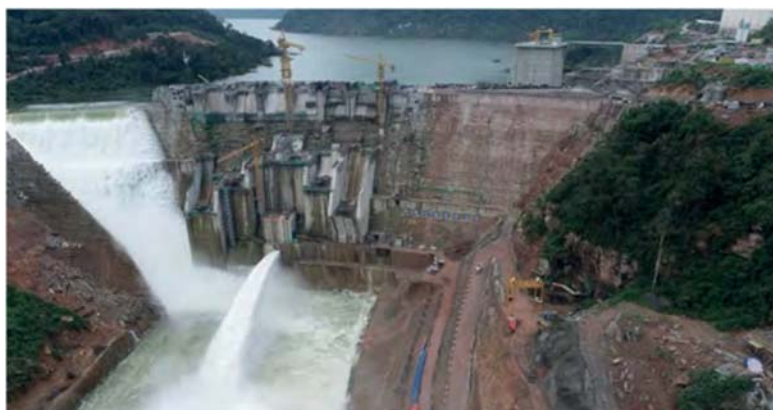
Přelévání RCC hráze dne 11.srpna 2021 ( Q=3\,878\text{ m}^3/\text{s} )
