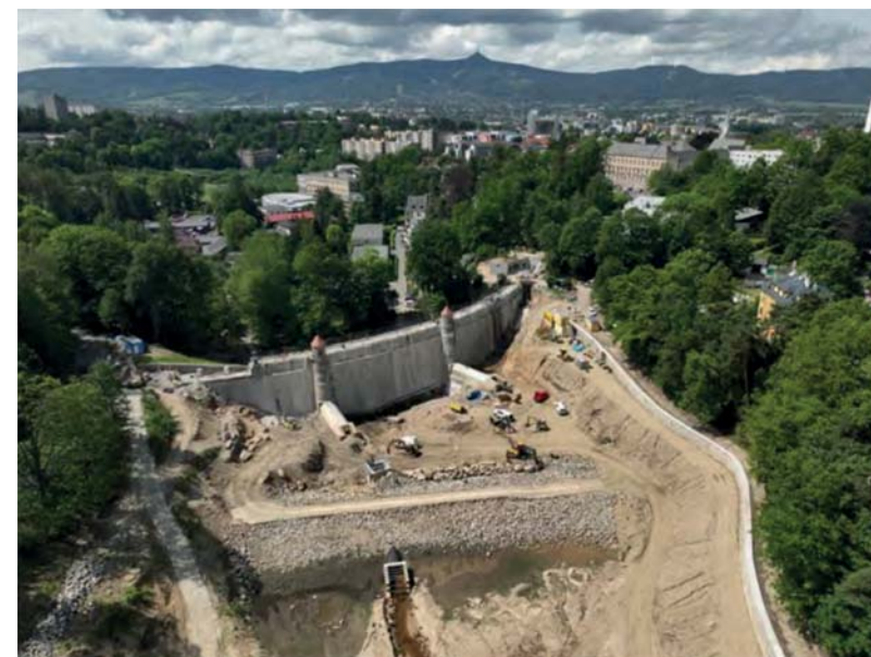
Pohled na staveniště v průběhu rekonstrukce
