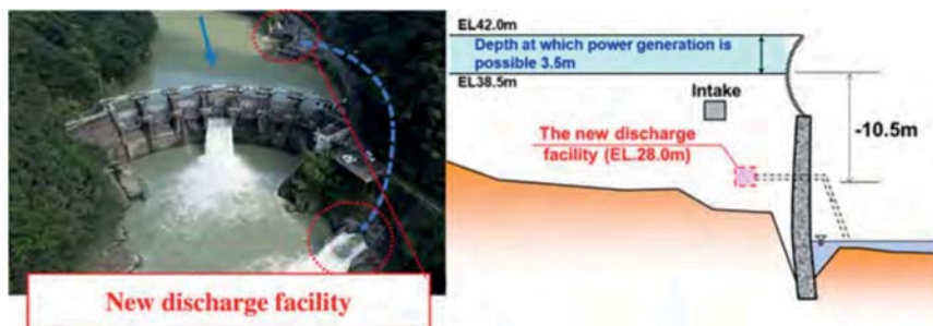
Nové výpustné zařízení
