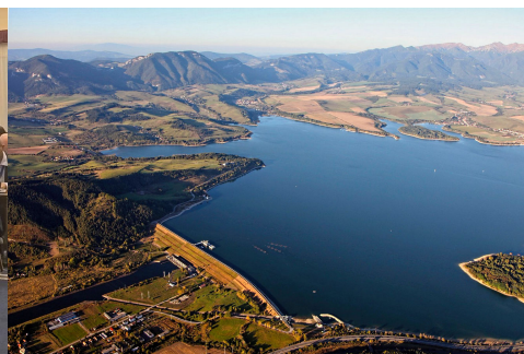
Letecký pohled na VD Liptovská Mara.
