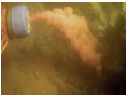
Obrázok 21 a 22: Na VE Mikšová sa najskôr realizoval prieskum s vyhotovením orientačného náčrtu, následne sa zdroj priesaku preinjektoval, po sanácii priesak ustal.
