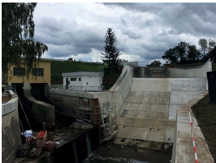
Obrázek 6: ... realita z provádění díla – stav před dokončením. Bílá budova uprostřed je horní stavba MVE.
