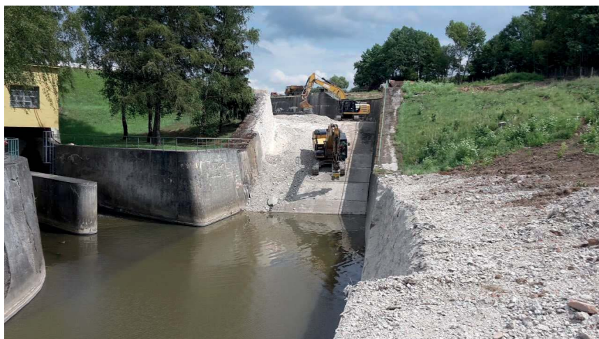
Obrázek 14: Bourání betonových konstrukcí bezpečnostního přelivu frézou – bagry na šikmé ploše skluzu jištěny řetězy.
