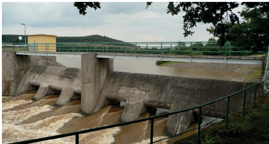
Obrázek 2: pohled na původní bezpečnostní přeliv – ve funkci okna pro převedení neškodného odtoku.
