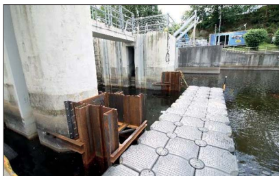
Obrázek 1: Pohled na provizorní drážky osazené v předpolí SV a segmentu na betonových pilířích.
