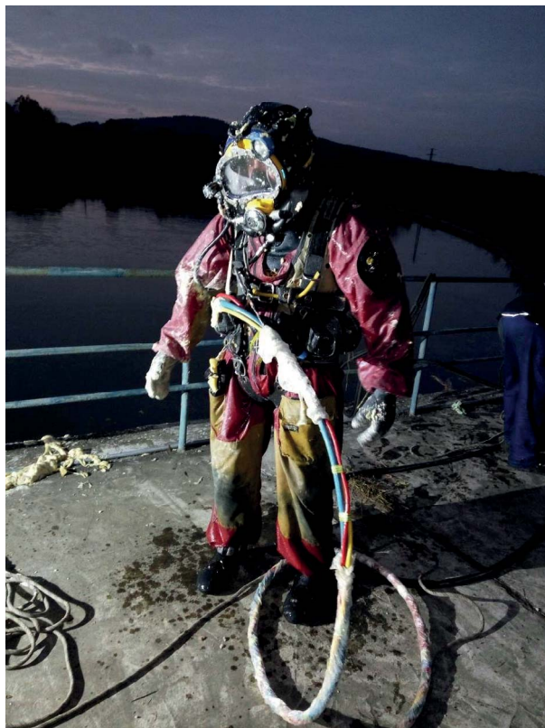
Obrázok 5: Potápač po ukončení injektážnych prác pod vodou na VE Mikšová.
