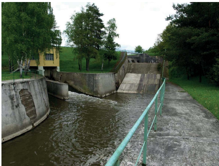
Obrázek 4: pohled na vývar (společný pro spodní výpusti a bezpečnostní přeliv, v pozadí skluz a přelivná hrana) ...
