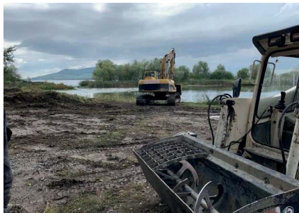
Obrázek 4. Míchací lžíce připojená ke smykovému nakladači typu UNC.
