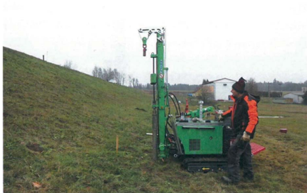
Obrázek 3: Provádění vrtu V4, resp. V24 [1].
