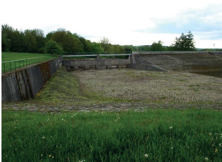
Obrázek 7: Pohled z nádrže VD na původní řešení bezpečnostního přelivu ...
