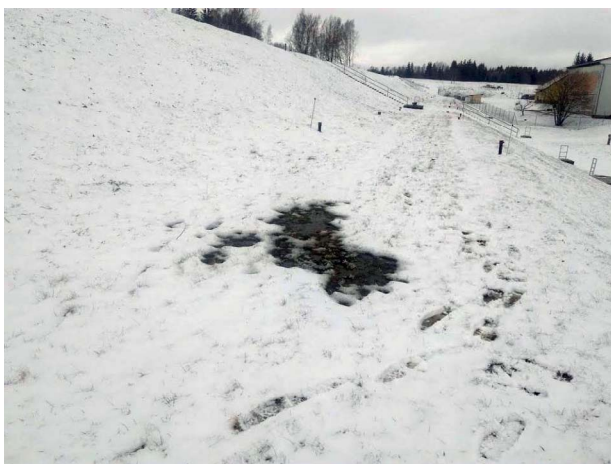
Obrázek 2: Zamokření v prostoru lavice vzdušního svahu.
