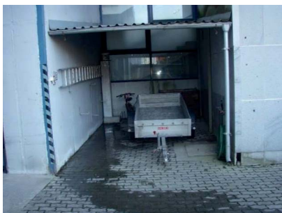
Obrázok 7 a 8: Priesaky vedľa budovy strojovne a na podlahe strojovne vodnej elektrárne.
