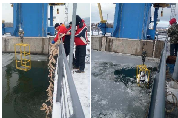
Obrázok 11 a 12: Dočasné utesnenie dilatačnej škáry dubovými klinmi.
