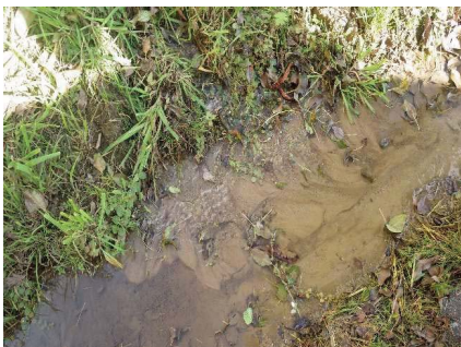
Obrázok 19 a 20: V roku 2016 bol za pomoci potápačov riešený priesak spoza ľavého vtokového krídla VE Mikšová.
