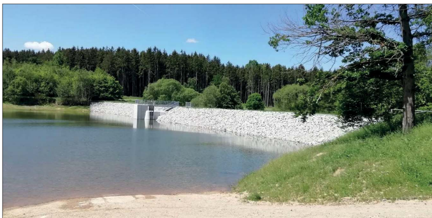
Obrázek 4: Dokončená stavba – napouštění nádrže.
