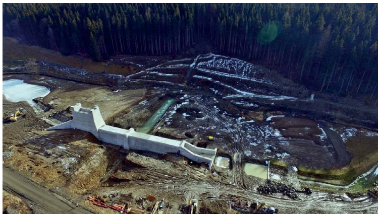
Obrázek 1: Výstavba SN Jelení.
