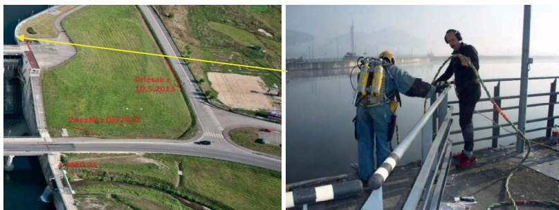
Obrázok 1 a 2: Pohľad na lokalitu priesakov za ľavým vtokovým krídlom a kontrola dilatanej škáry potápačmi.
