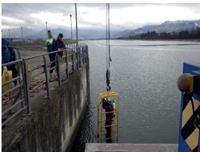
Obrázok 13 a 14: Utesnenie vrtu v mieste dilatácie polyuretánovou penou a následný kontrolný potápačský prieskum.
