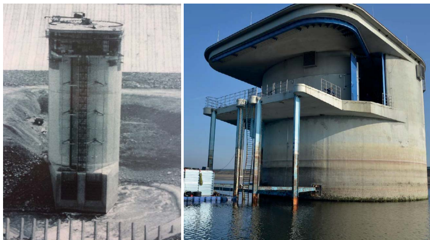
Obrázek 1 a 2: Věžový objekt s předsaženou konstrukcí vedení hradidel před uvedením do provozu a v současné době.
