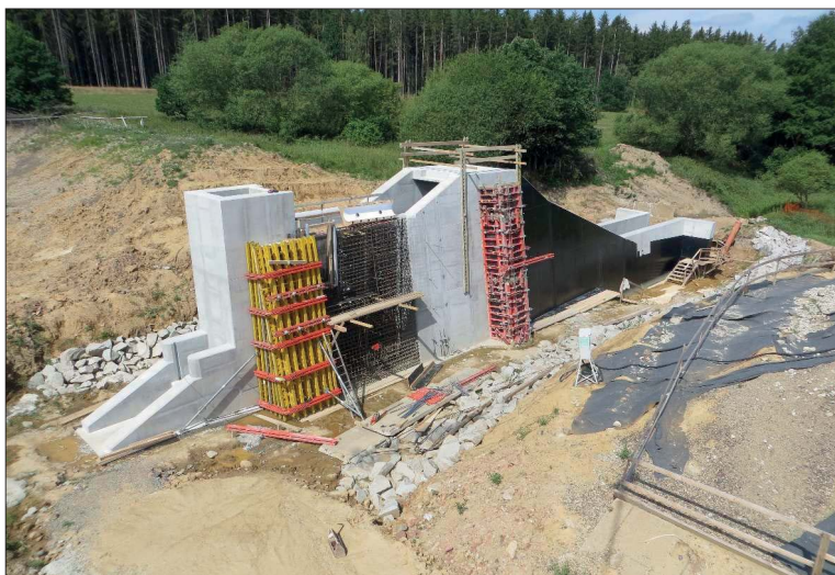
Obrázek 3: Realizace sruženého objektu v otevřené jámě (příčný překop hráze).
