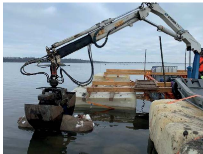
Obrázek 8. Výrobek č. 3, vak plněný Obrázek 9. Ukládání výrobku č. 3 do nádrže. solidifikovaným sedimentem.
