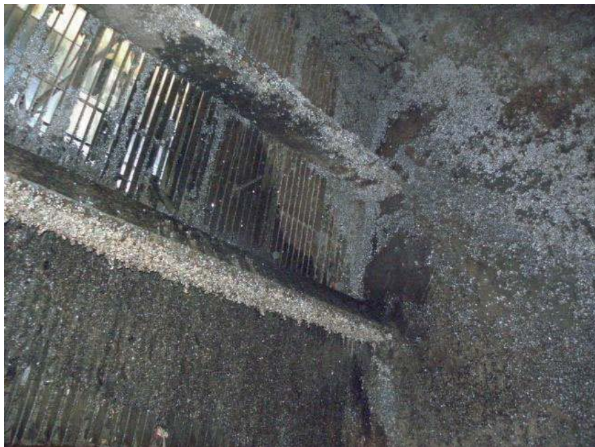
Obrázok 4: Hrablice VE Nosice „obrasnené“ lastúrami kopytka prirasteného.
