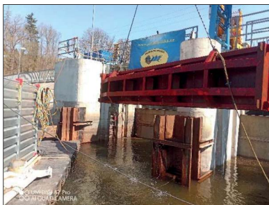
Obrázek 3: Zavěšené hradidlo při přehrazování vtoků v provizorní ohrázce.
