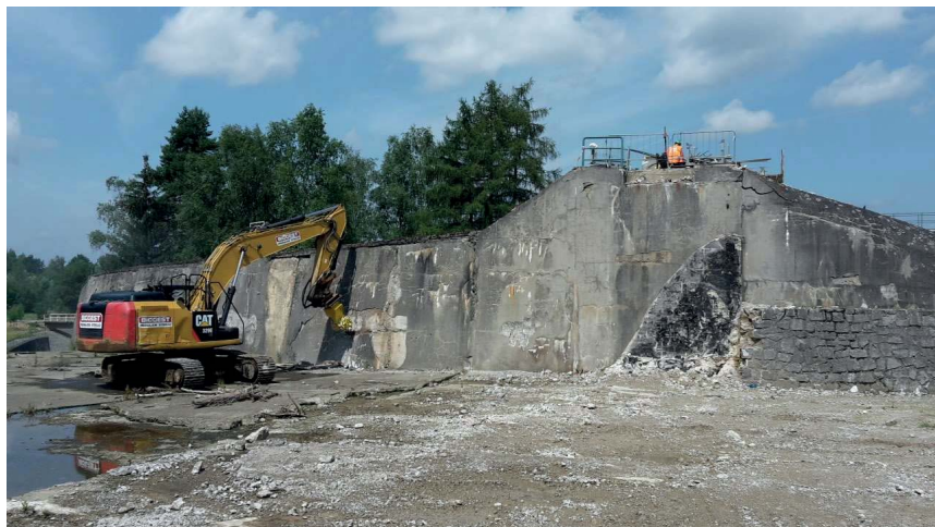
Obrázek 13: Bourání betonových konstrukcí bezpečnostního přelivu frézou. Na stěně přelivu patrný tvar již odbourané přelivné hrany.
