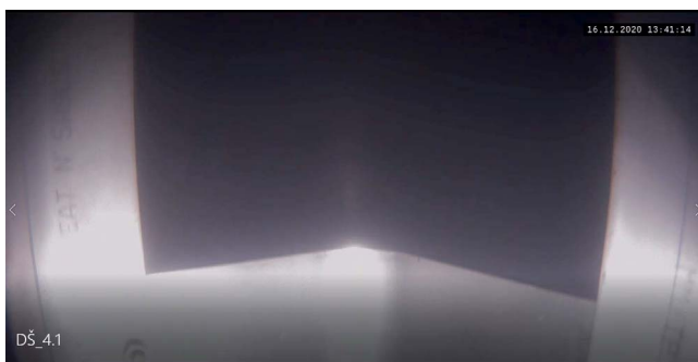
Obrázok 10: Účinnosť tesniaceho pásu pri otvorenej dilatáčnej škáre (VV – TBD).
