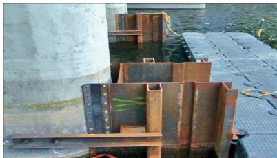
Obrázek 2: Pohled na osazené těsnění provizorních drážek ohrázky na betonových pilířích.
