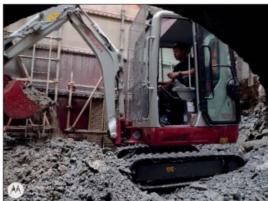
Obrázek 6: Nakládání vybourané betonové suť pomocí pracovního stroje Takeuchi TB216 v prostoru spodních výpustí (pohled z potrubí SV).
