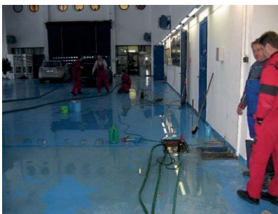
Obrázok 7 a 8: Priesaky vedľa budovy strojovne a na podlahe strojovne vodnej elektrárne.
