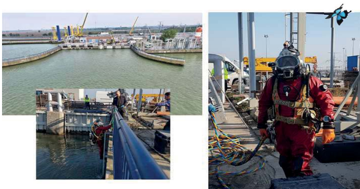
Obrázok 7: Pohľad na vtokový objekt PLK a jeho sanáciu potápačmi (VV – TBD).
