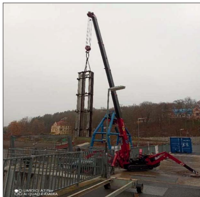
Obrázek 7: Montáž nových nerezových drážek pomocí pavoučího jeřábu UNIC 95.
