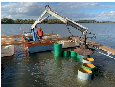
Obrázek 16. Práce s hydraulickou rukou při zatlačování ocelových sudů do dna nádrže.
