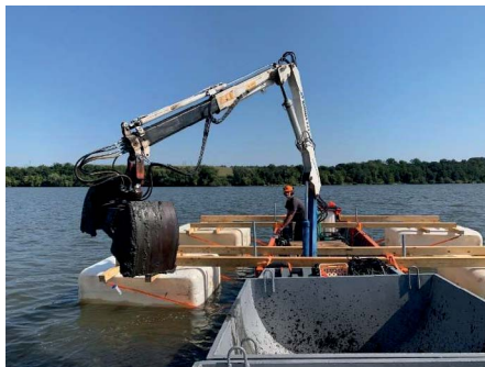
Obrázek 2. Průběh těžby sedimentu ze speciální lodi za pomoci dvakrát lomené hydraulické ruky vybavené drapákem s rotátorem.
