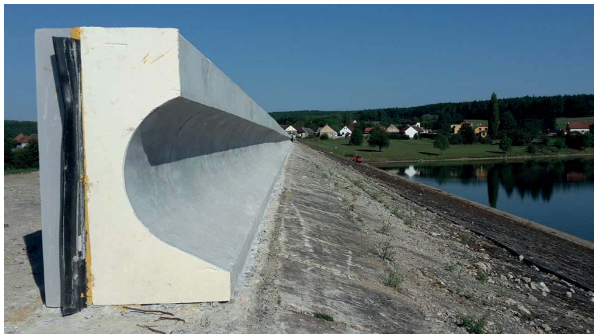
Obrázek 15: Nový vlnolam propojený s těsnicím jádrem hráze umožní zvýšení mezní bezpečné hladiny.
