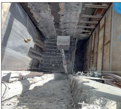
Obrázek 5: Pohled na pracovní plošinu s pracovním bouracím strojem Takeuchi TB216 změna techniky i technologie bourání.
