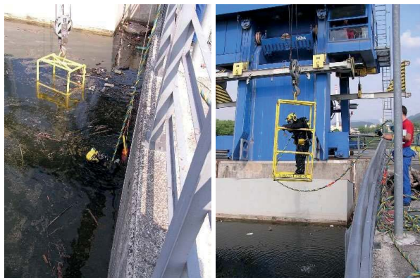
Obrázok 9 a 10: Kontrola dilatácii medzi 1. blokom pravého vtokového krídla a VE.
