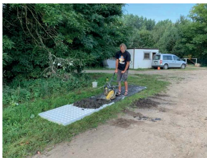
Obrázek 6. Plnění zušlechťeného sedimentu do formy a jeho udusání.
