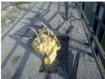
Obrázok 13 a 14: Utesnenie vrtu v mieste dilatácie polyuretánovou penou a následný kontrolný potápačský prieskum.
