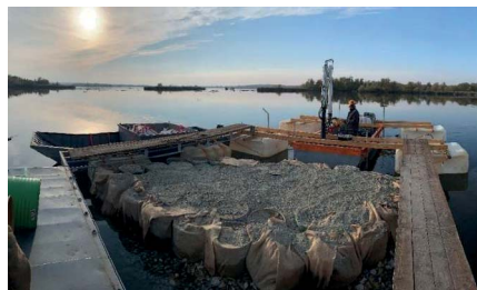
Obrázek 18. Základ zkušební polygonu „ostrova“ - zasypán a překryt jutovou tkaninou.
