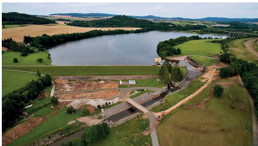
Obrázek 1: pohled na hráz VD Klabava před zahájením rekonstrukce.
