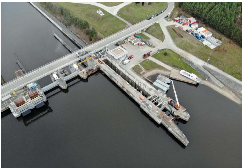
Obrázek 22: Letecký snímek na vodní dílo – v rekonstrukci horní ohlavi plavební komory a jedno ze dvou rekonstruovaných poli bezpečnostního přelivu.
