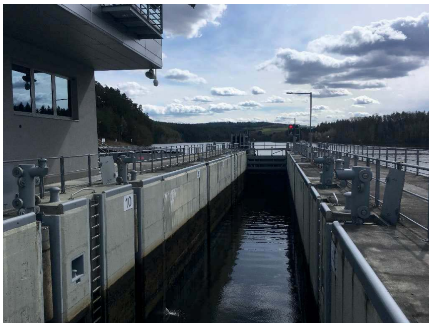
Obrázek 2: Pohled do plavební komory proti vodě.
