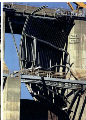
Obrázek 5: Folsom Dam, California 1995, havárie segmentu.
