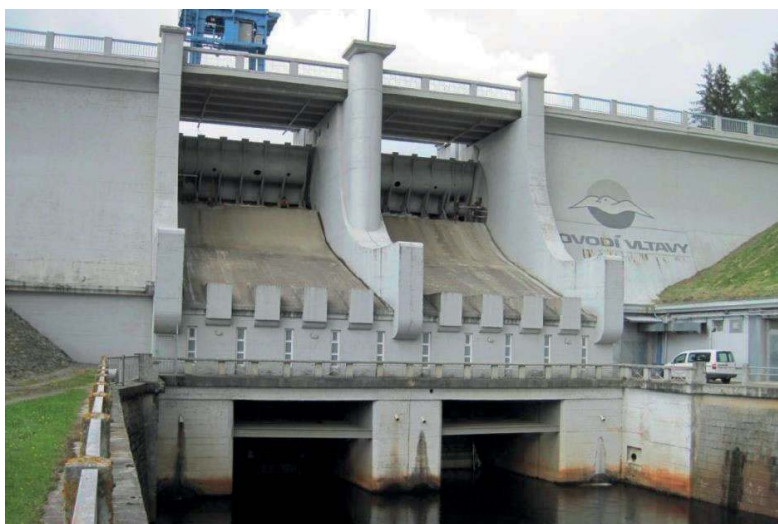
Obrázek 1: Těleso hráze s klapkami přelivu VD Lipno I.
