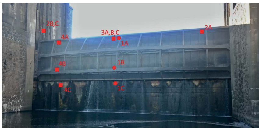
Obrázek 10: Rozmístění měřicích bodů na konstrukci stavidla.
