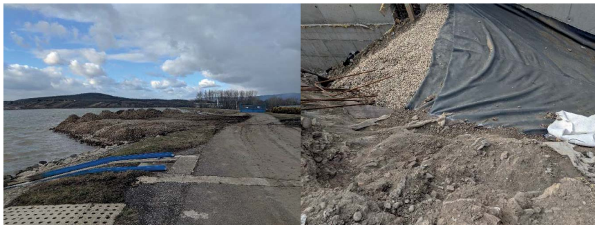
Obrázok 4: vľavo – Dočasná zemná ohrádzka; vpravo – Spoj nového a jestvujúceho fóliového plášťového tesnenia LOH.
