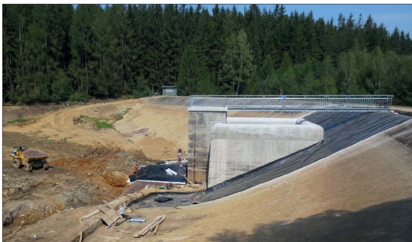
Obrázek 3: Sanace návodního těsnění – instalace fólie HDPE tl. 3 mm.
