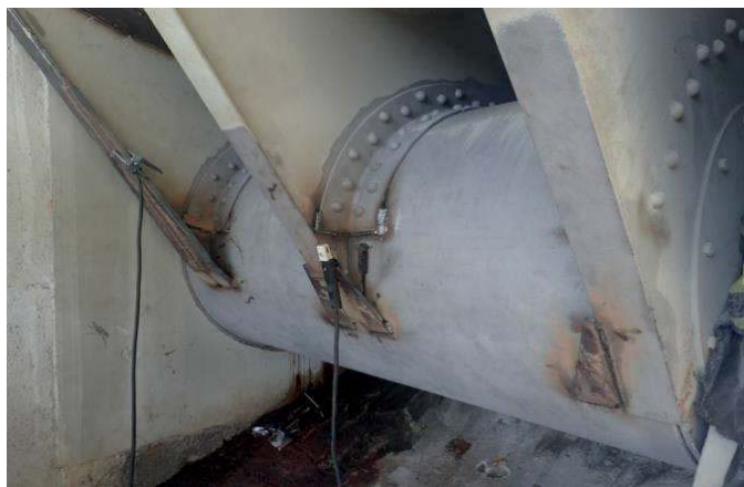
Obrázek 5: Vnější výztuhy a posílení ovládací trubky klapky.
