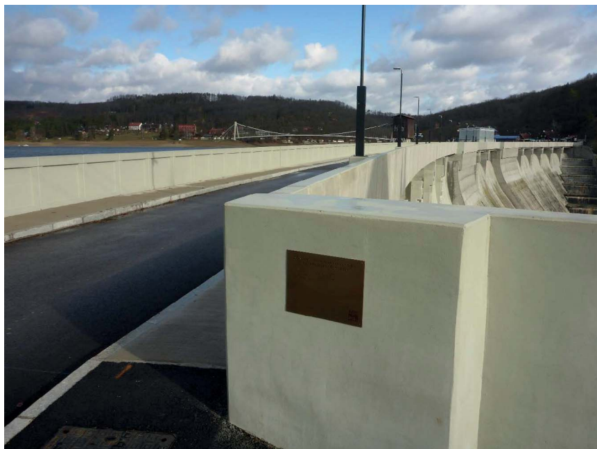
Obrázek 2: Celkový pohled po rekonstrukci.
