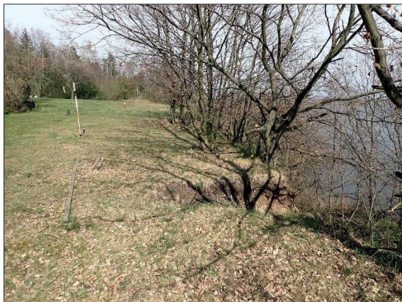
Obrázek 2: Prostor okraje odlučné stěny sesuvu v těsné blízkosti zástavby osady Oáza se systémem monitorovacích vrtů a bodů.
