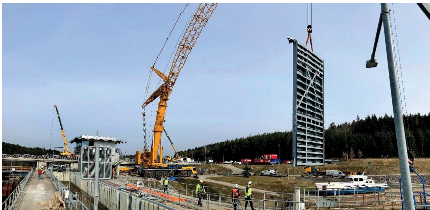
Obrázek 20: ... a vlastní montáž nových horních vrat plavební komory.
