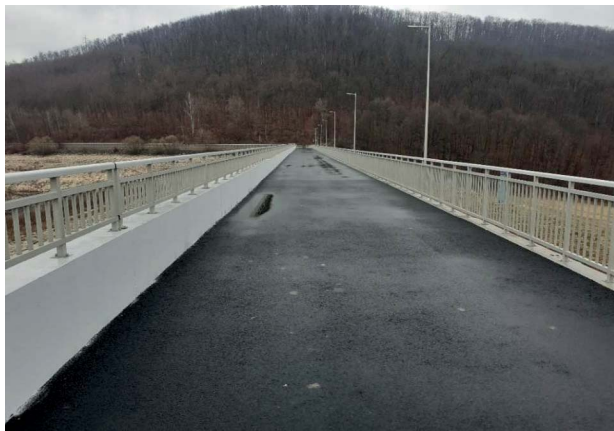
Obrázok 3: Koruna hrádze po oprave.
