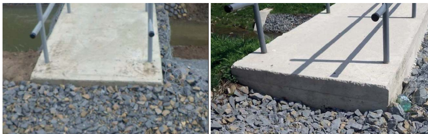
Obrázok 2 a 3: Vývoj poklesu koruny hrádze poldra v mieste kontaktu s prehrádzkou, 15.10.2015 (vľavo) a 02.05.2018 (vpravo)
