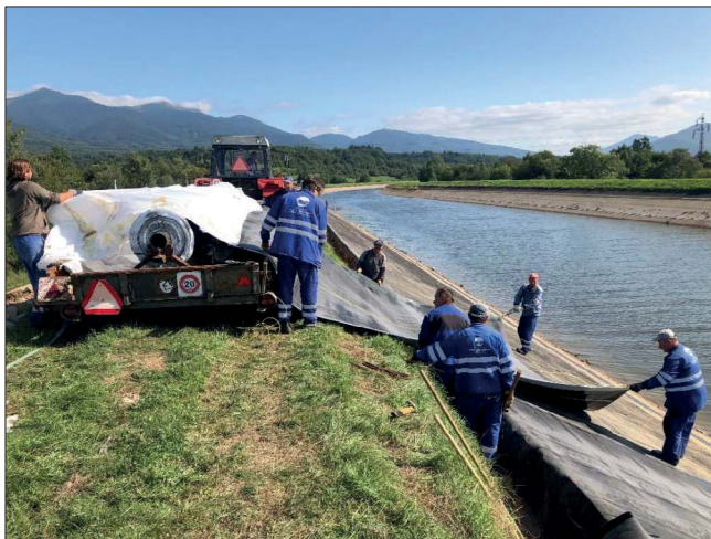
Obrázok 4: Pokládka geomembrány – Coletanche ES2.
