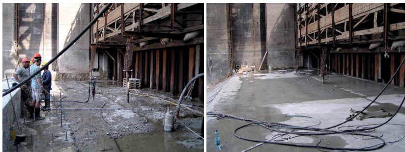
Obrázek 5: levý snímek – vybouraný prostor po kamenných obkladech, pravý snímek – nová železobetonová deska.
