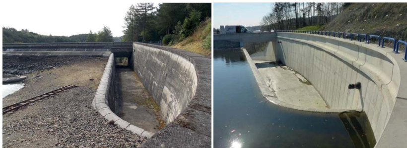
Obrázek 3.: SO 02 Bezpečnostní přeliv a SO 03 Přemostění skluzu.
