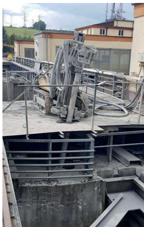
Obrázok 2: Jadrový vrt do piliera pre novonavrnuté kotvy.
