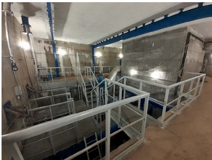
Obrázok 6: Objekt strojovne po oprave.
