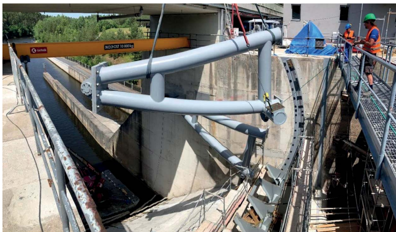
Obrázek 15: Montáž částí nového segmentového uzávěru.
