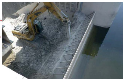
Obrázek 13: Rekonstrukce přelivu: příčný řez, průběh bouracích prací.
