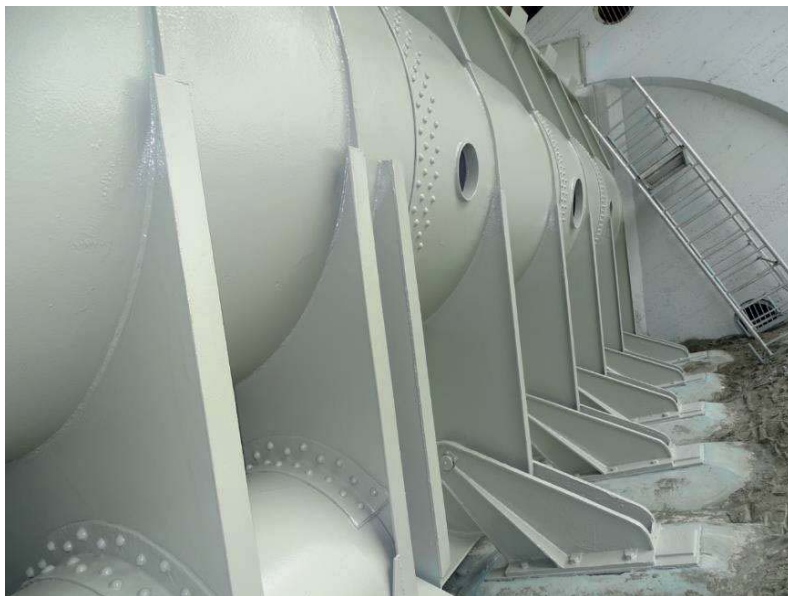
Obrázek 7: Nová protikoroziční ochrana klapky.
