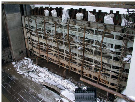
Obrázek 4: Pohled na ochrannou návodní jímku.
