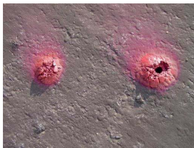
Obrázek 6: Puchýřky identifikované 4 roky po dokončení opravy AB pláště.
