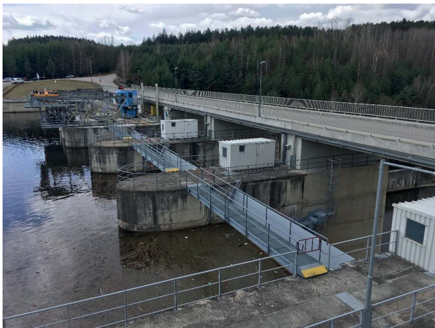
Obrázek 3: Pohled z velínu plavební komory na tři pole bezpečnostních přelivů.
