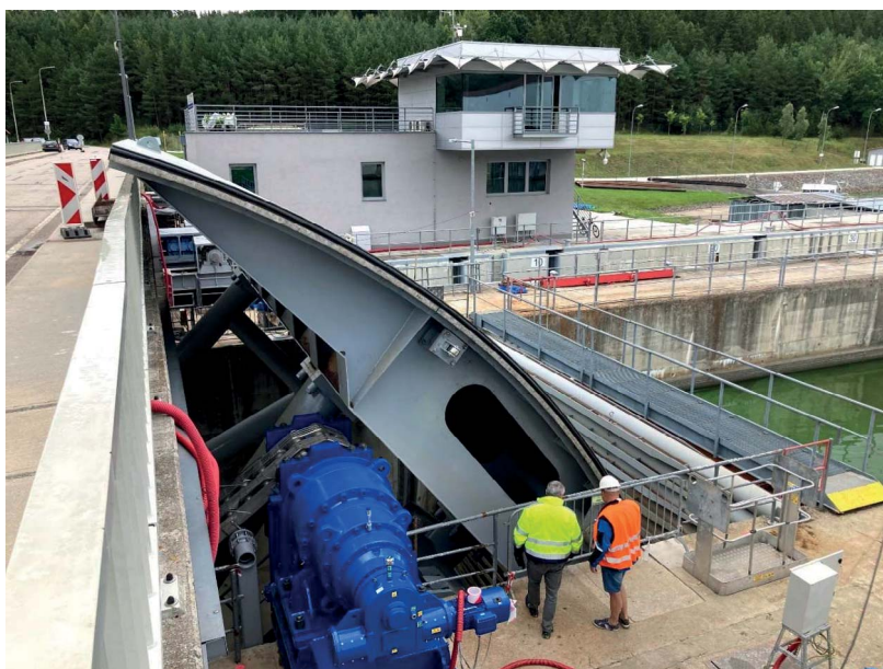
Obrázek 16: Suché zkoušky segmentového uzávěru.
