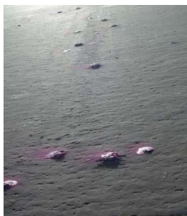
Obrázek 6: Puchýřky identifikované 4 roky po dokončení opravy AB pláště.
