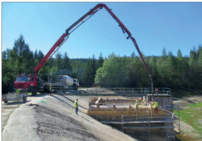
Obrázek 4: Betonáž přelivné hrany na sdruženém objektu.
