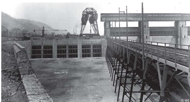
Obrázek 2: Celkový pohled na slupicovou konstrukci po její instalaci v roce 1934, spodní část zalita do betonu.
