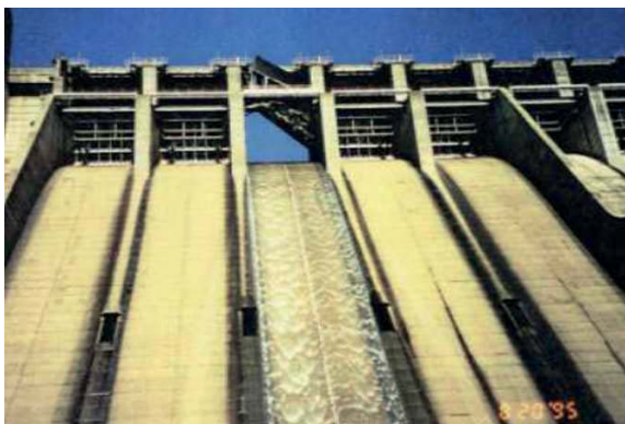
Obrázek 5: Folsom Dam, California 1995, havárie segmentu.
