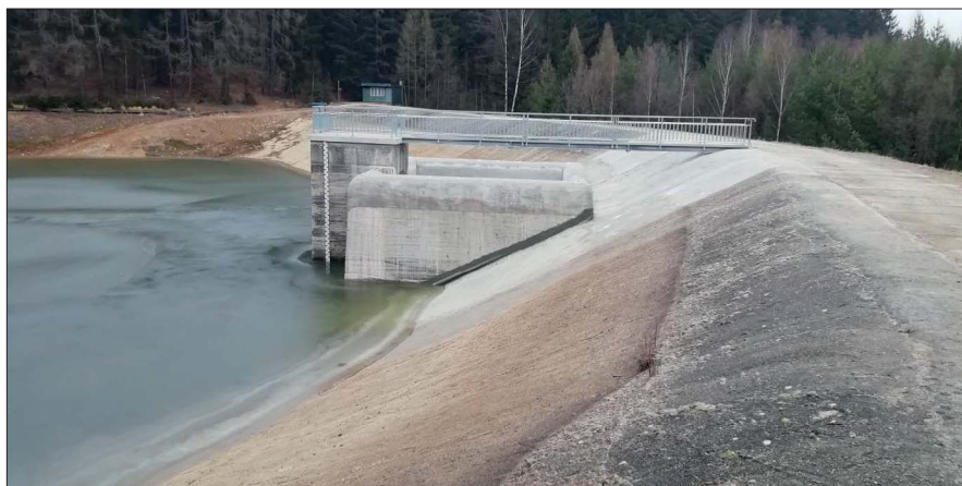
Obrázek 5: Dokončená stavba – napouštění nádrže.
